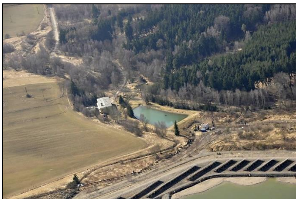
Obr. 22 Areál bývalého Š-11
