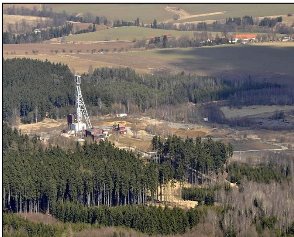
Obr. 19 Bývalý důl Jasan (jámy R-2 a R-3)
