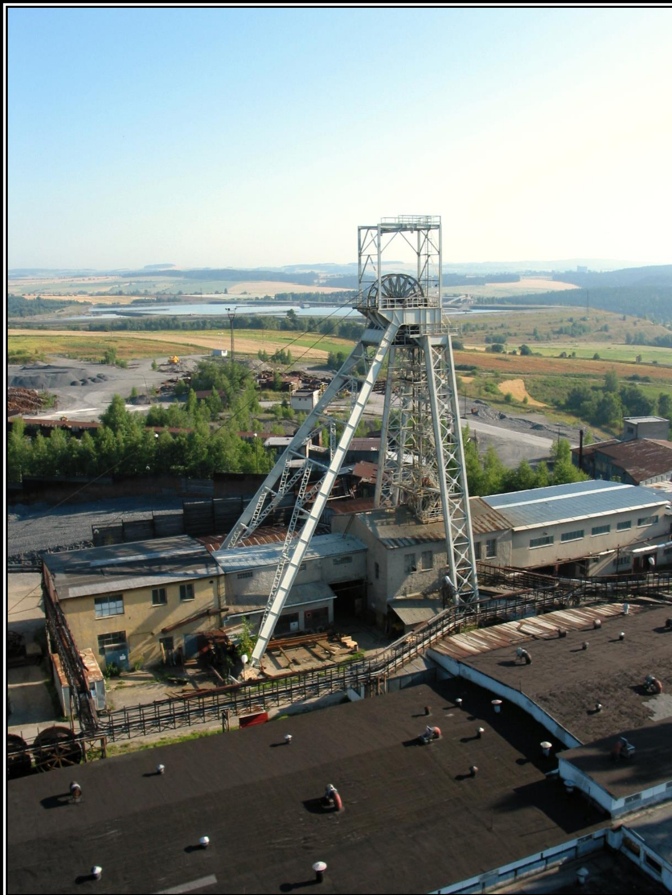
Věž první těžní jámy R1 na ložisku Rožná. Hloubení této jámy začalo v roce 1957. Bylo dosaženo hloubky 668 metrů na úrovni 14. důlního patra. Po většinu doby aktivní těžby, která skončila v roce 2016, sloužila R1 jako hlavní těžní jáma. Fotografie: archiv DIAMO o. z. GEAM Dolní Rožínka.
