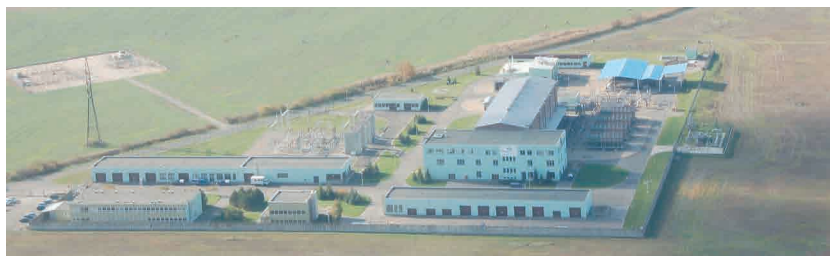
■ Povrchová infrastruktura podzemního zásobníku zemního plynu Dolní Dunajovice
